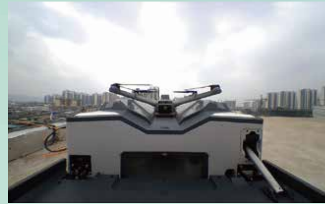
无人机机场建设
